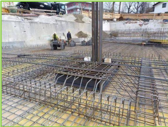
LOSAS DE CIMENTACION CON ZAPATAS
