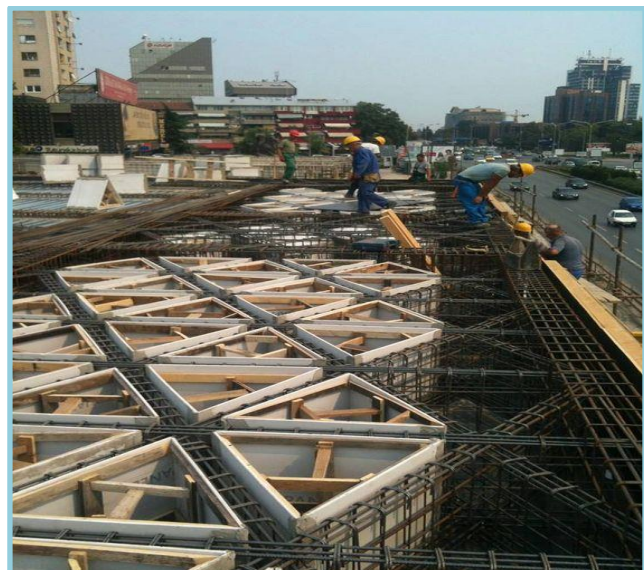
LOSA NERVADA CON VIGAS FORMAS GEOMETRICAS
