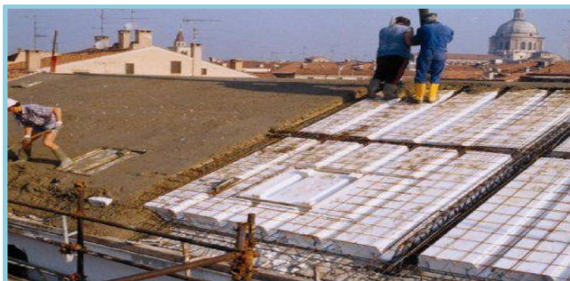
LOSA PREFABRICADA CON ACERO
