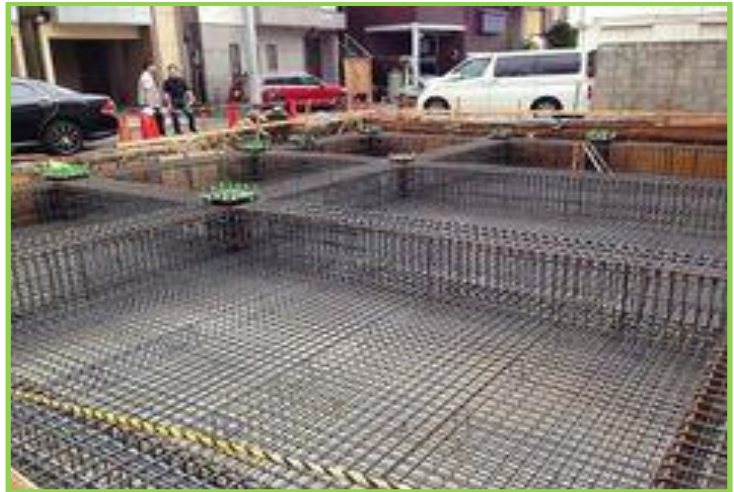
LOSAS DE CIMENTACION CON VIGAS CONECTORAS
