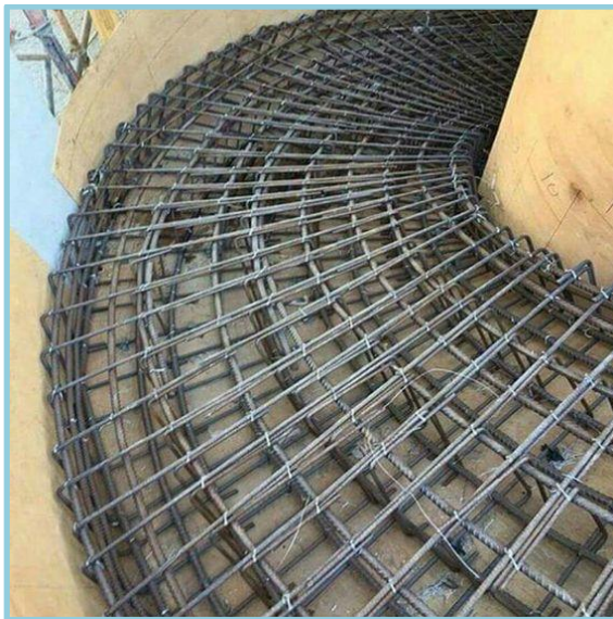
GRADAS EN ESPIRAL DE ACERO REFORZADO
