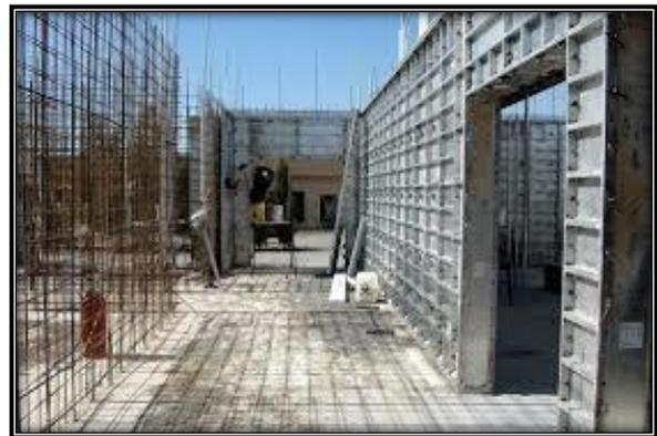
La construcción industrializada es un sistema de construcción cuyo diseño de producción es mecanizado, en el que todos los subsistemas y componentes se han integrado en un proceso global de montaje y ejecución para acelerar su construcción.
